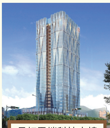
長虹雲端科技大樓 纖維水泥架高地板
