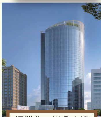
振業化工辦公大樓 纖維水泥架高地板
