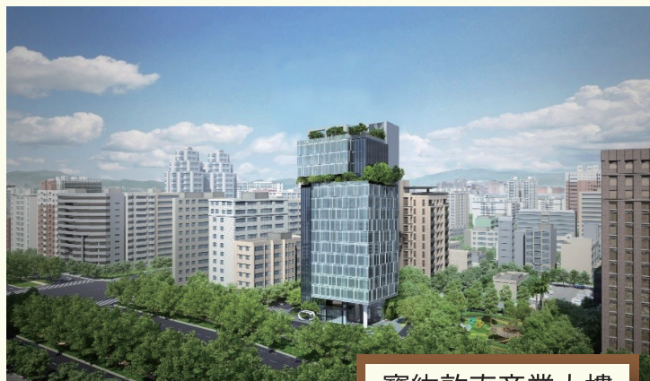
寶紘敦南商業大樓 纖維水泥架高地板
